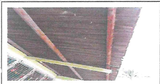
Foto 1: Techo y estructura destruido por los fuertes vientos y oxidada por la antigüedad.
