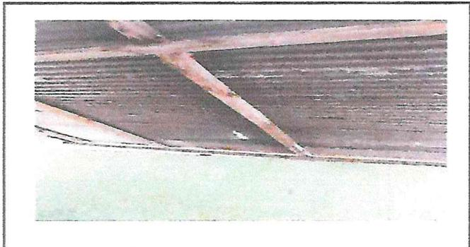
Foto 3: Estructura de madera y lamina en mal estado.
